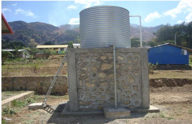
**Figura 21. Modelu rezervatóriu/tanke bee no plataforma/bajé/tore**
